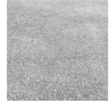
Béton désactivé de la place
