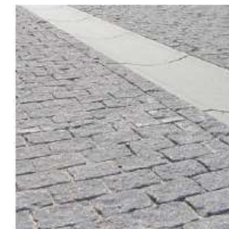
Le filet d'eau qui contraste avec le pavage
